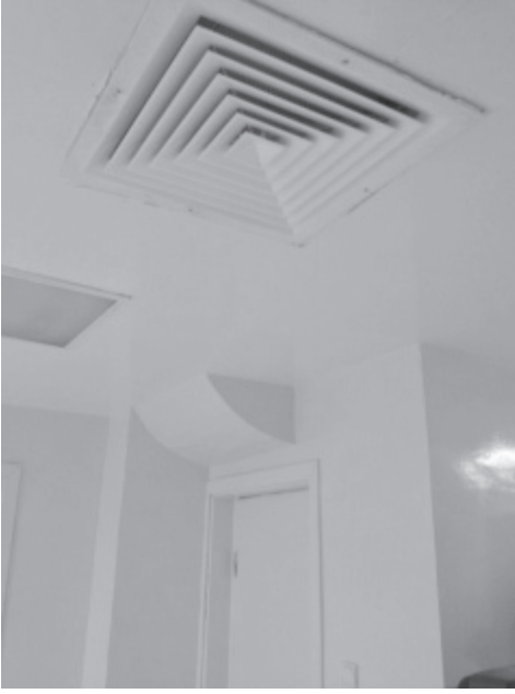
Resim 1. Laboratuvar havalandırma sistemi
